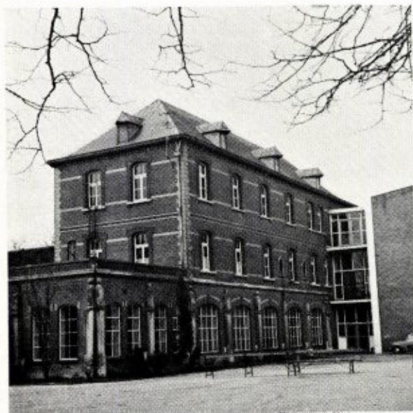
Vleugel van het kloostercomplex te Cadier en Keer, waarin het veldstation gevestigd zal worden. foto R. R. van W.
